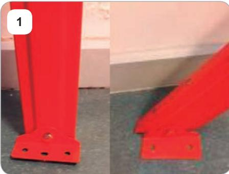
Colocar las fijaciones al piso (H), a las patas delanteras y traseras.
